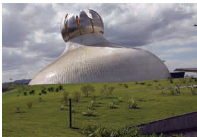
A abertura da “flor” idealizada por Lelé para a iluminação interna do auditório
