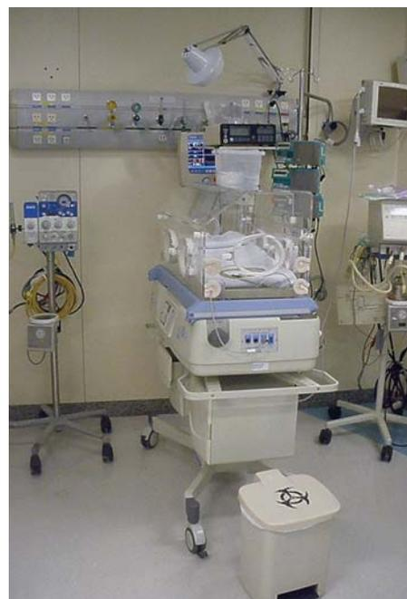
**Figura 02 - Detalhe de uma incubadora com as necessidades de instalações e equipamentos**
