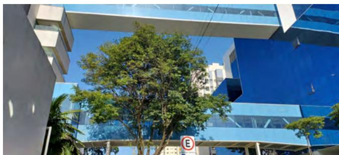
Figura 4: Passarelas metálicas de ligação entre blocos do hospital. | Fonte: Acervo pessoal da autora, 2022.
